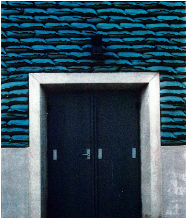
L’acoustique a été particulièrement soignée dans un quartier très bruyant le jour et silencieux la nuit. Les sacs de mélange indestructible assurent la masse.
