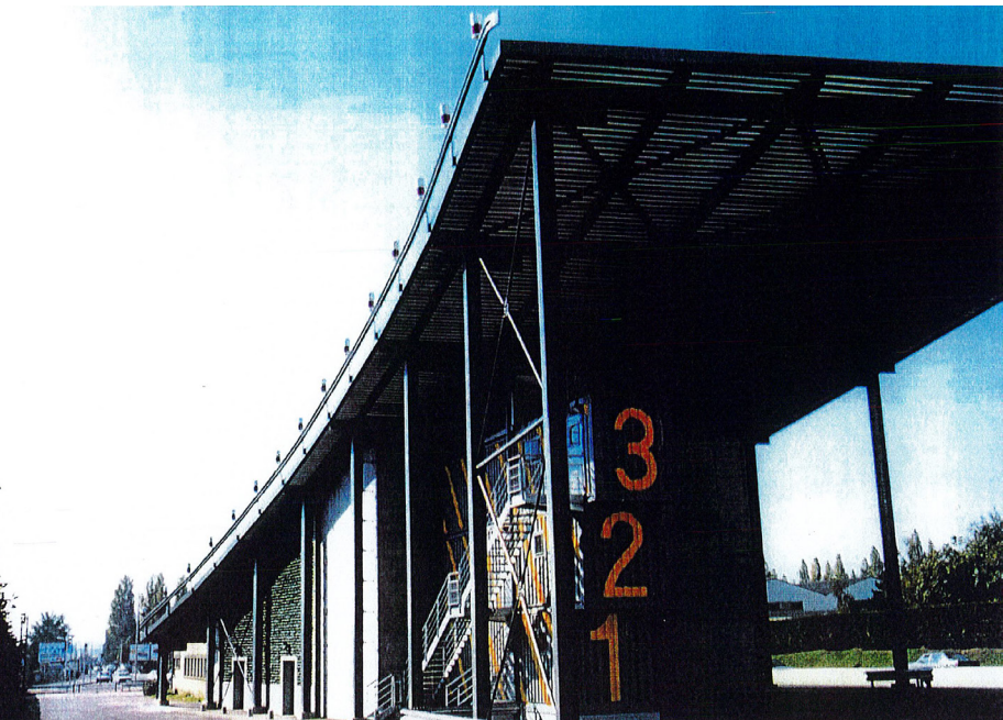
Des containers “dernier voyage” sont recyclés pour devenir des loges. Empilés les uns sur les autres, ils forment des paliers utilisés par l’escalier de scène.
